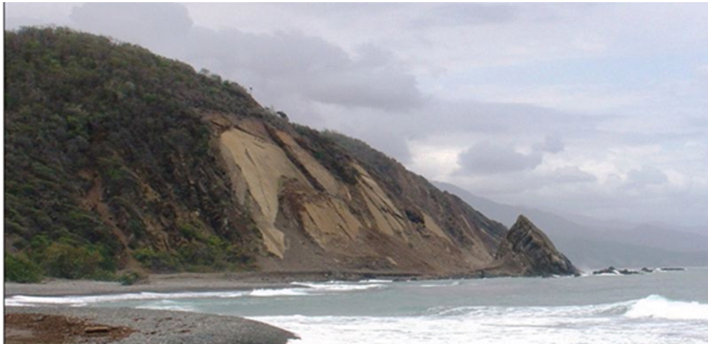
Figura 5. Deslizamiento traslacional al sur de la Sierra Maestra, carretera de Pílon, provincia Granma. Se desconoce su antigüedad. Foto tomada por Pérez-Aragón (2014).
