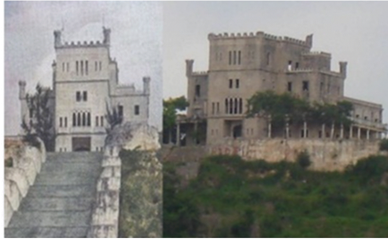
Figura 16. El llamado “deslizamiento” del Mariel, provincia Artemisa, clasifica como una corriente lenta de tierra o arrastre. Fotos de Archivo
