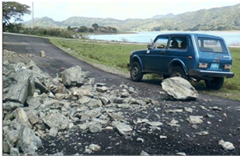
Figura 7. Desprendimiento de rocas metasilíceas en una ladera del macizo metamórfico Guamuhaya, provincia Cienfuegos. Foto tomada de Gómez-Brito et al., (2013).
