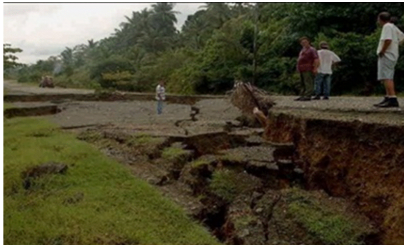
Figura 13. Movimiento de ladera de expansión lateral o reptación, ocurrido en Nibujón, provincia Horguín. Foto por cortesía de Luis Bernal-Rodríguez IGP/SGC.
